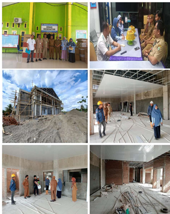
Gambar 31 Koordinasi di Dinkes Mamuju Tengah dan kunjungan ke lokasi pembangunan Labkesmas tier 2 mamuju Tengah
